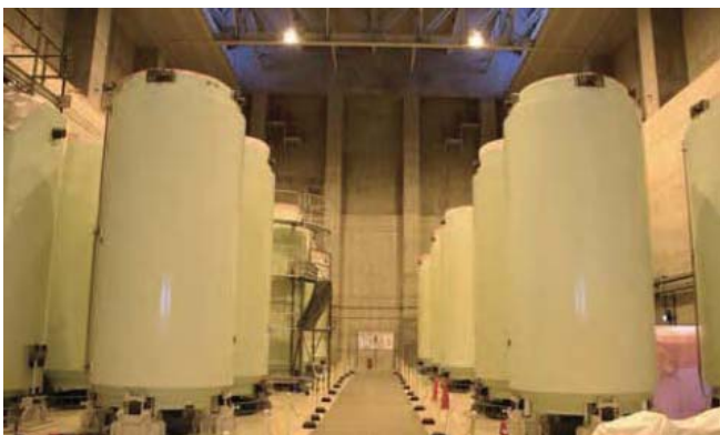
日本原子力発電(株)東海第二発電所(乾式貯蔵方式) (発電所敷地内)
