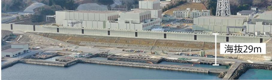
海拔29mの防潮堤設置。防潮堤の沈下防止・安定性向上のため、地盤改良等を実施。
