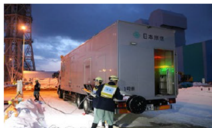
電源車からのケーブル敷設訓練
