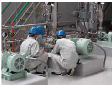
設備の保守点検作業
