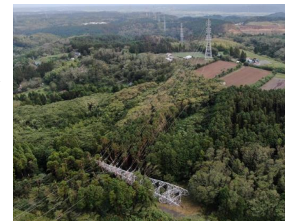
鉄塔設備の倒壊（君津市）
