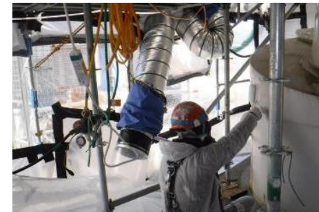
厳冬期屋外現場の作業状況
