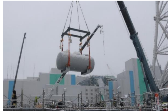
薬品貯槽を大型クレーンで地下8mにある設置場所へ据付
