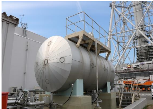
薬品貯槽 (硝酸ヒドラジン受入れ貯槽)
