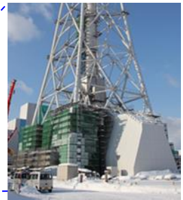
防護板の設置状況
