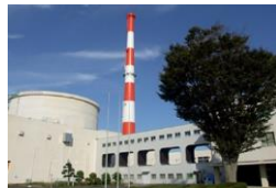
高速実験炉「常陽」
