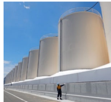
(図1) ALPS処理水を保管する巨大タンク
