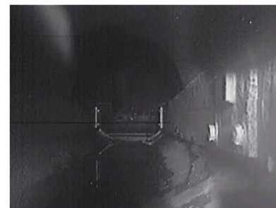
<除去作業完了（貫通孔内）>
