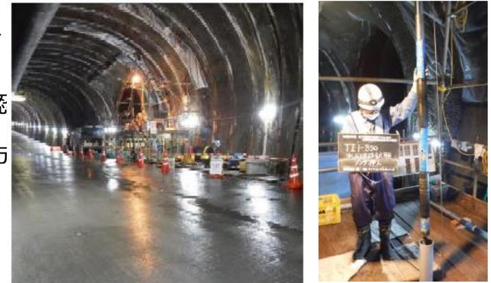
試験空洞における地圧測定の様子
