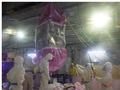
バーナブルポイズン切断装置の点検 (水中中部品の吊り上げ作業)
