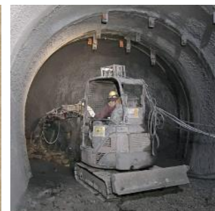
【止水プラグの原位置施工試験】
