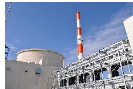
「常陽」の安全対策工事の状況 (耐震補強の例)
