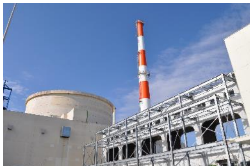
高速実験炉「常陽」の安全対策工事の状況 (耐震補強の例)
