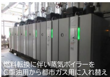
燃料転換に伴い蒸気ボイラーをC重油用から都市ガス用に入れ替え お客さま先の燃料転換によるCO 2 削減をJ-クレジット化(四国ガス)
