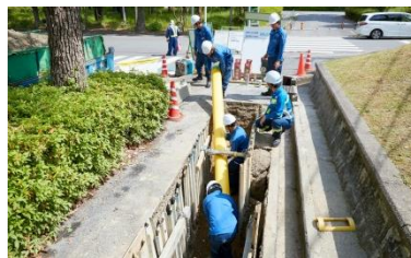
ポリエチレン管への更新
