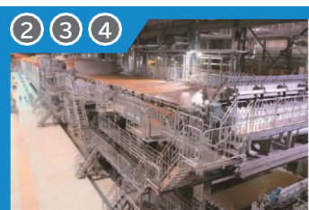
しょうしき 抄紙機(紙製造設備)
