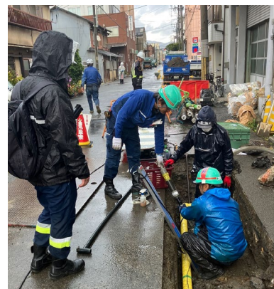
ポリエチレン管施工現場
