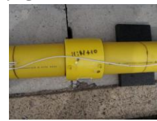
PE管の接合部
