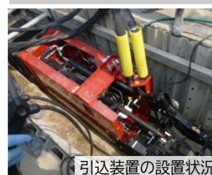
引き込み装置の設置状況
