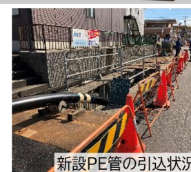
新設PE管の引き込み状況
