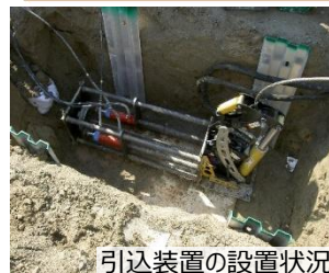
引き込み装置の設置状況
