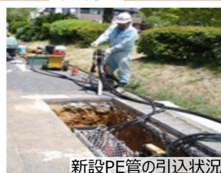
新設PE管の引き込み状況
