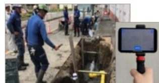
配管敷設状況を1往復で動画撮影
