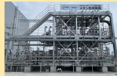
SOEC (大阪ガス) メタン製造10Nm 3 /h級
