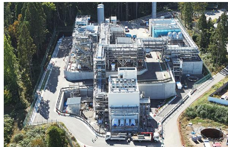
施工中のメタネーション試験設備の外観
