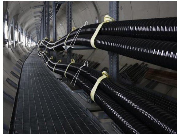
地下トンネル（洞道）内部
