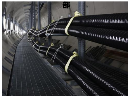
地下トンネル（洞道）内 部
