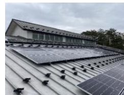
武道館における太陽光発電設備設置（福知山市）
