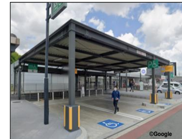
ペロブスカイト太陽電池設置予定箇所(近景) (提供:NEXCO西日本)
