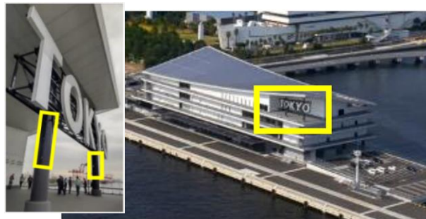
東京国際クルーズターミナル 4階デッキ (出典:積水化学工業HP)
