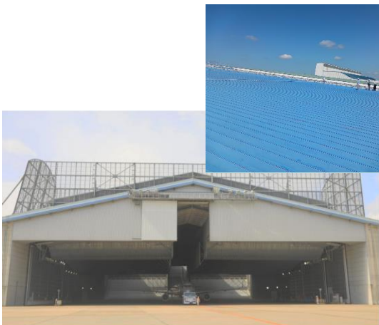
ハンガー屋根への設置可能性 (耐荷重の低い屋根)
