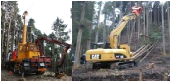
タワーヤード・スイングヤード
