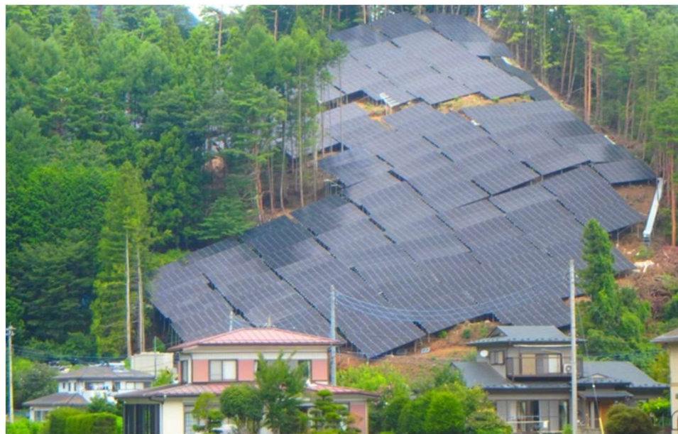
森林伐採し、斜面に設置された事例
