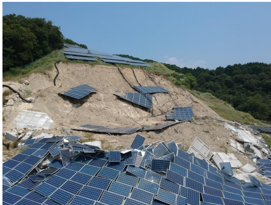
＜兵庫県姫路市 西日本豪雨被害＞
