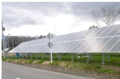
(柵塀未設置の事例)
