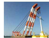
港湾での風車の設置組立
