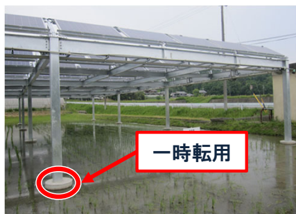
▲ 営農型太陽光発電設備の例
