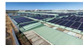
下水処理場の上部空間を活用した太陽光発電
