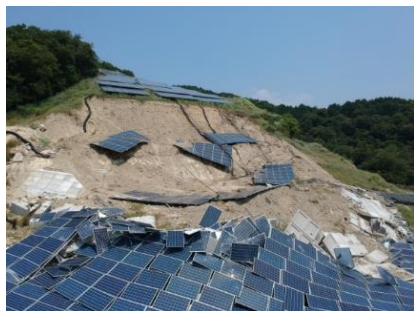
土砂崩れで生じた崩落
