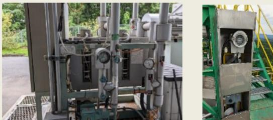
凍結対策を実施したドラムレベル計、ボイラ薬品ライン
