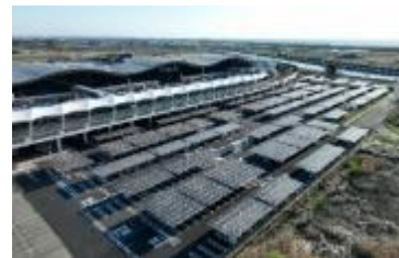
※写真提供：仙台空港再エネ発電合同会社
