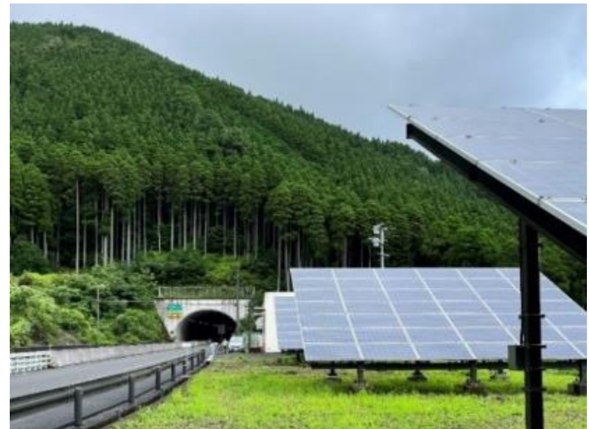
東九州自動車道 大長瀬トンネル坑口(九州地方整備局)
