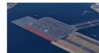
羽田空港の滑走路着陸帯 （舗装部）
