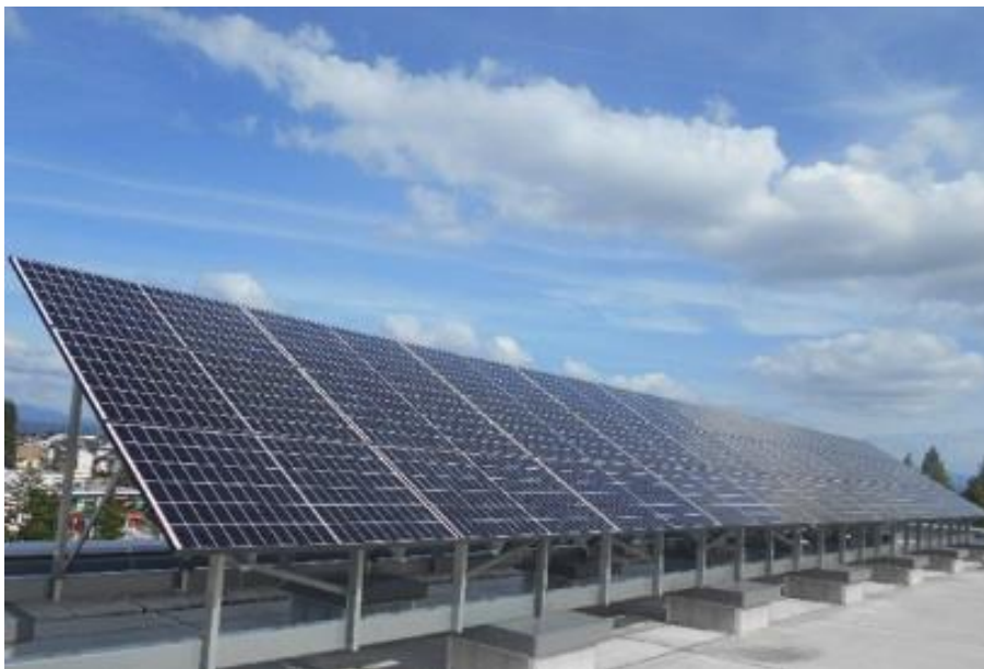
管理事務所上屋への設置(東日本高速道路(株)) 東北自動車道 郡山IC
