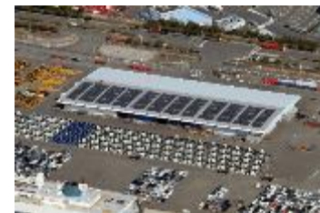
横浜港における太陽光発電設備
