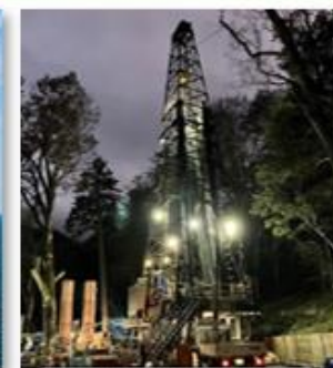
調査井掘削状況 (地熱)
