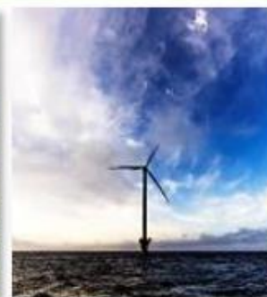
銚子沖 洋上風力発電所
