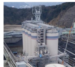
敦賀火力発電所燃料貯蔵サイロ
