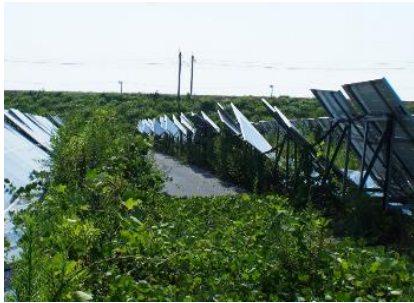
不十分な管理で放置されたパネル
