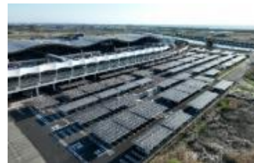
※仙台空港再エネ発電合同会社提供
