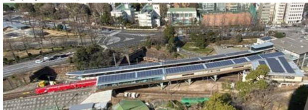
【東京地下鉄・四ツ谷駅】
