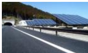
道路における太陽光発電の活用
