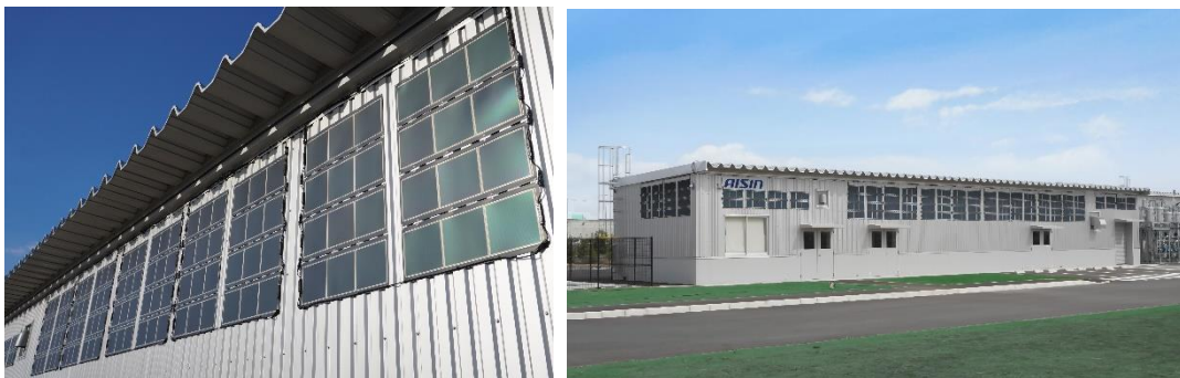
株式会社アイシン：自社安城工場敷地内施設における実証（右は設置完了イメージ図）
