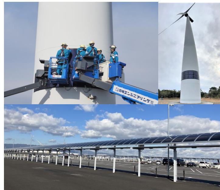
積水化学工業株式会社： 風力発電所への設置（上） 関西・大阪万博バスターミナルへの設置（下）
