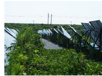
不十分な管理で放置されたパネル
