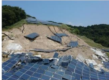
土砂崩れで生じた崩落
