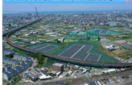
泉佐野市長湊第1/第2水上太陽光発電所
