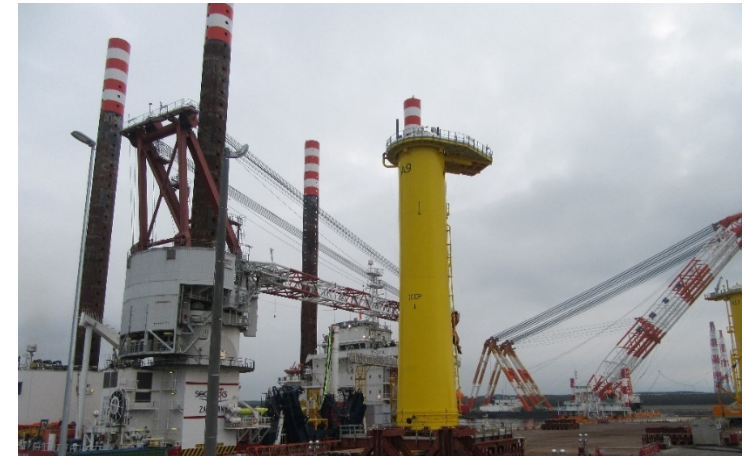
トランジションピース積み込みの様子
