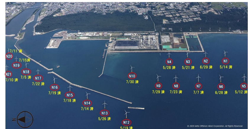
能代港内の設置工事進捗状況 (R3.8.2時点) (AOW提供)
