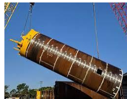
サクションアンカー 探査深度：30m
