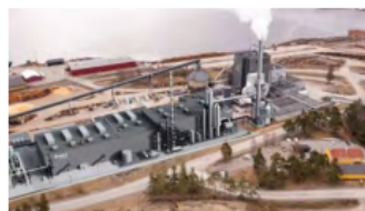
スウェーデン北部に欧州最大規模となる年間製造能力55,000トンの合成メタノールプラントを建設し、2025年稼働開始予定だった。
