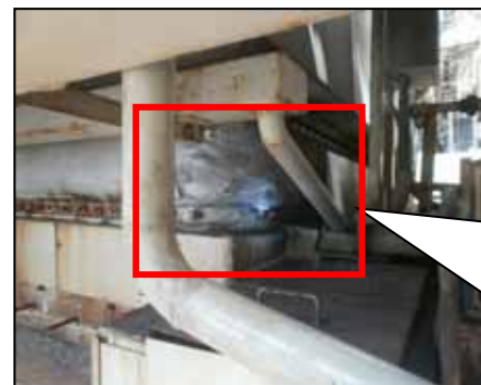
空気予熱器の伸縮継手部
