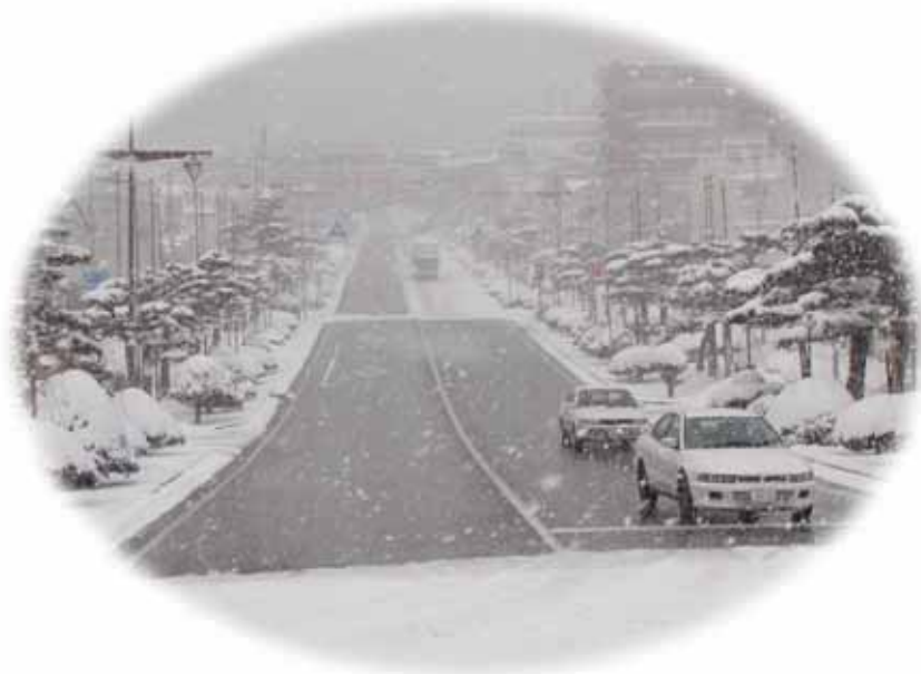
ロードヒーティングを用いた融雪により路上の安全を確保
