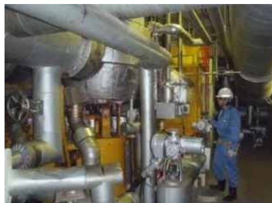
現場でのパトロール状況
