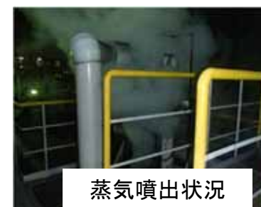
図 すず吹き装置の蒸気漏れ
