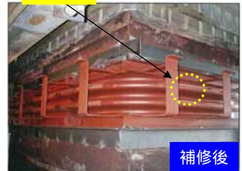
・ボイラー排ガスの通路であるダクトや伸縮継手が、腐食により破口し、ガスリークが発生している
