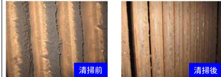
・ボイラーの管に灰が付着し、熱伝達が阻害されるため、局部過熱の懸念がある
