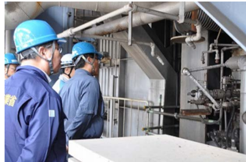
九州電力 荻田発電所
