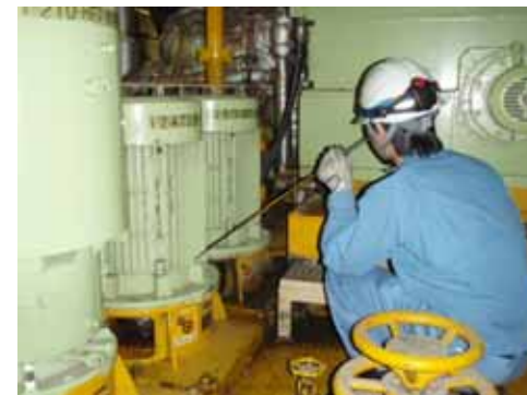
現場でのパトロール状況
