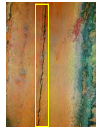
亀裂発生状況
