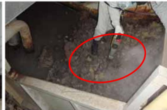
削岩機による灰の塊の破碎作業
