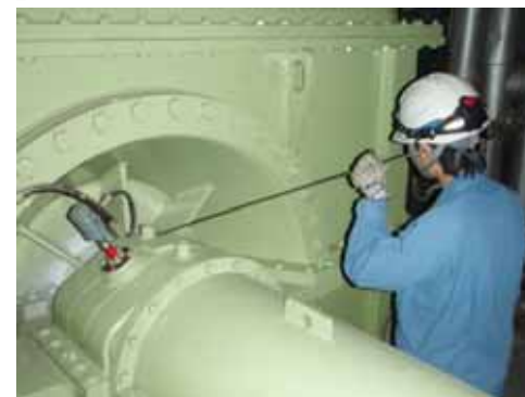
現場でのパトロール状況
