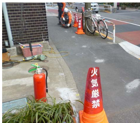
漏れ箇所を探す②
