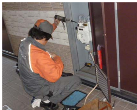
漏れ箇所を探す①
