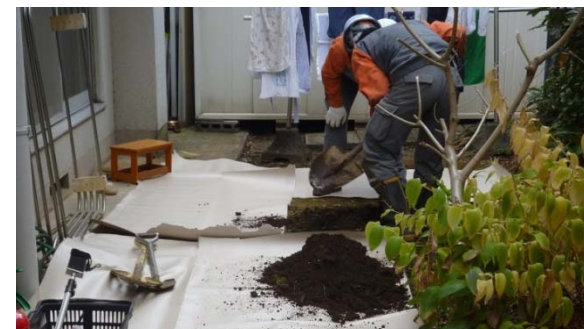
漏れ箇所を応急修理する
