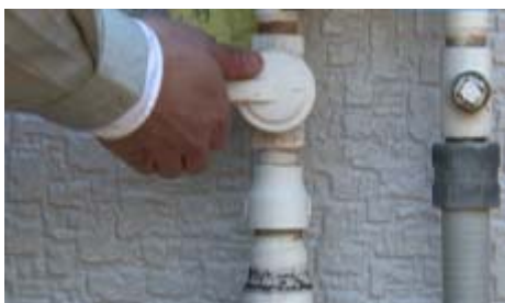
■ メーターガス栓 閉⇒開へ操作
