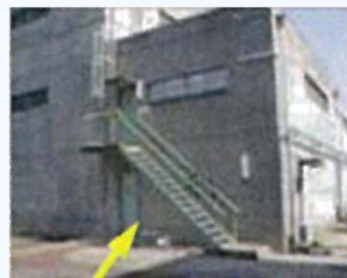
扉を水密扉に交換
